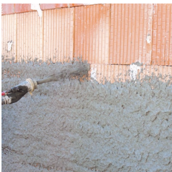
Obr.1 Nástřík omítky pomocí omítačky.
