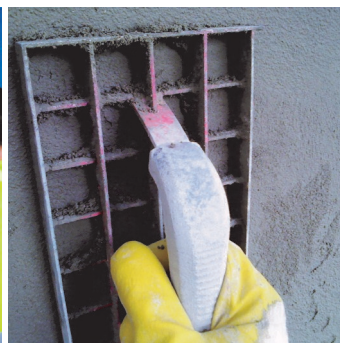
Obr.4 Následující den strhnout povrch škrábákem.
