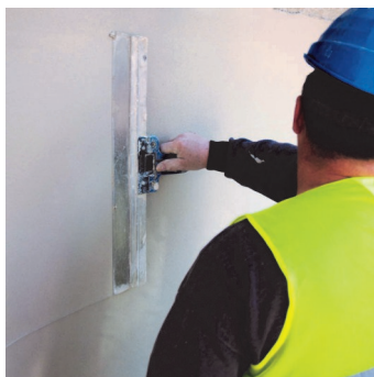
Obr.3 Urovnání povrchu fasádní špachtlí.
